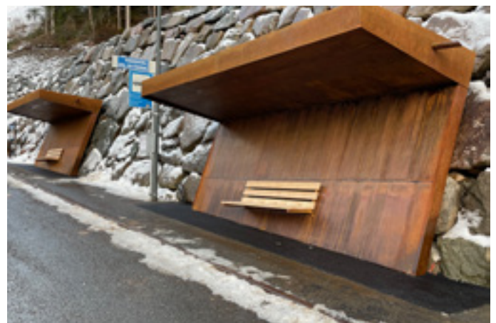
Die neuen Buswartehäuschen bei der Bushaltestelle „Zentrum“ sind fertiggestellt worden und stehen dem Publikum zur Verfügung.
